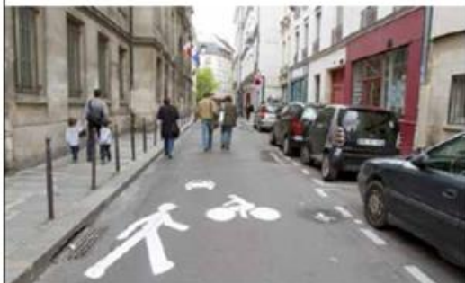
Marquage en entrée de zone de rencontre, complémentaire de la signalisation verticale (panneau B52)
