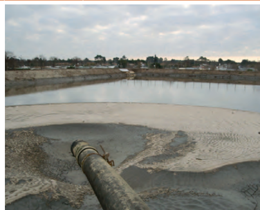
Le Bassin de décantation de Verdalle, zone de rejet
