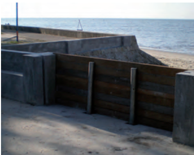
Après travaux : réalisation d'un ouvrage de protection appelé «batardeau».
