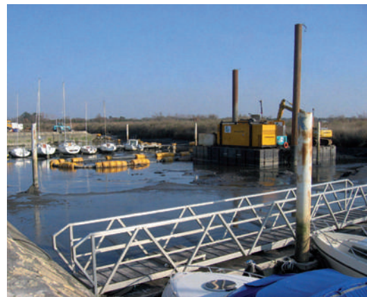
Extraction des sédiments de la darse sud févr 08
