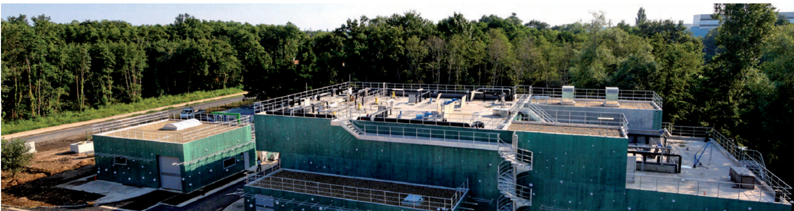
Station d'épuration de Biganos
