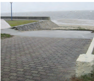
Avant travaux : quartier du Mauret à Andornos-les-Bains.
