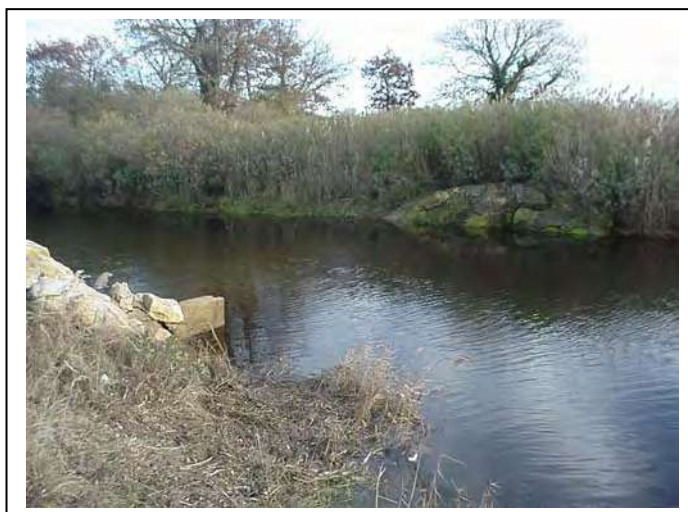
EMPLACEMENT POUR BATARDEAU
