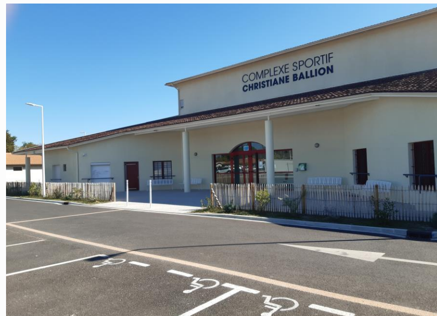
Travaux au complexe sportif Christiane Ballion
